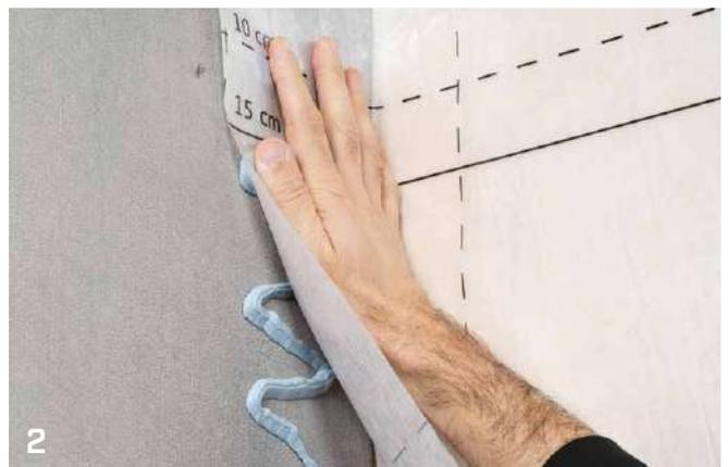
CONNESSIONE MEMBRANA IN COPERTURA - CALCESTRUZZO
