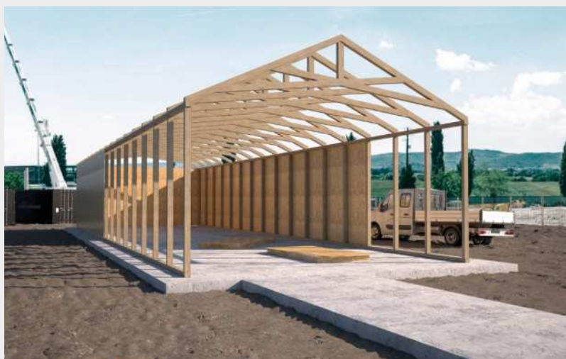
Fixação de treliça de madeira em ambiente exterior.
