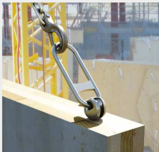
フックWASPと全ねじVGSを使用して吊上げて輸送するためのシステム。
