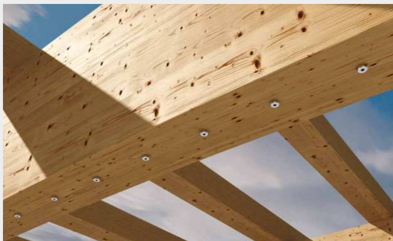
大断面集成材の梁へ繊維直交方向に補強。
