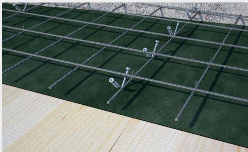
Forjado colaborante madera-hormigón en panel CLT con disposición de conectores a 45° en fila individual.
