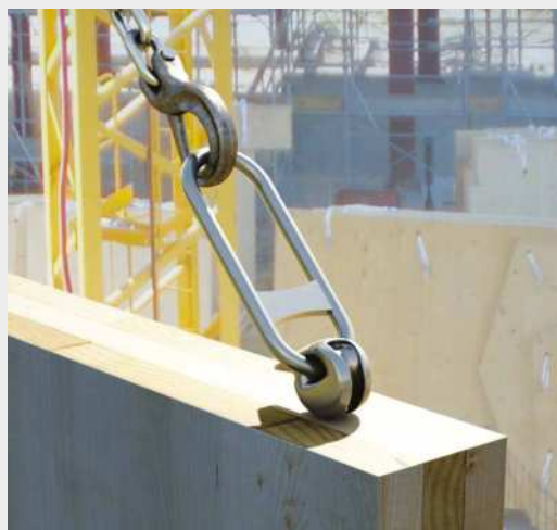
^ Celšanas un transporta sistēma, izmantojot WASP āķi un VGS skrūvi.
